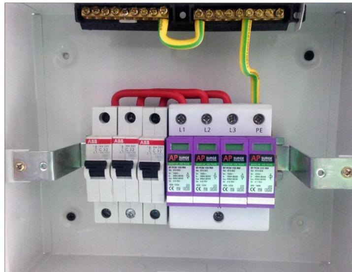
Es un dispositivo de protección contra sobretensiones, que brinda una protección completa para su hogar. Con todos los niveles de protección (Línea-Línea, Línea- Neutro, Línea-Tierra) que lo hace un sistema confiable y seguro.
